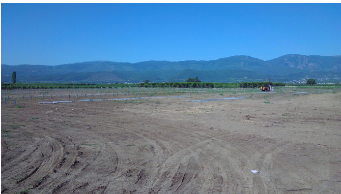
Πάρκο Φ/Β 500KW στα Μονόσπιτα Ημαθίας στη φάση της πασσαλόμπτυξης
