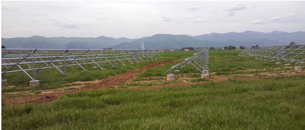
Πάρκο Φ/Β 100KW στη Ξάνθη
